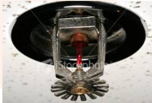
Recessed Pendent Sprinkler Head จะต้องใช้ Escutcheon Plate ที่ ออกแบบมาสำหรับหัว Sprinkler รุ่นที่ทำการติดตั้งเท่านั้น
